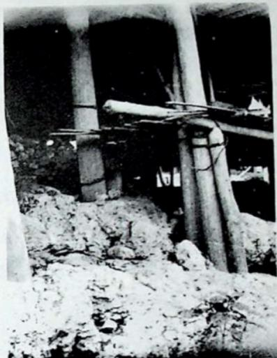
Ukuran bangunan : panjang 18 meter – 23 meter, lebar 16 meter – 18 meter. Tinggi 4 meter – 5 meter. Tinggi menara joglo 4 meter – 6 meter. Garis tengah tiang utama  $\frac{1}{2}$  meter – 1 meter. Jumlah seluruh tiang 30 batang – 36 batang. Jumlah usuk 150 batang – 200 batang.
