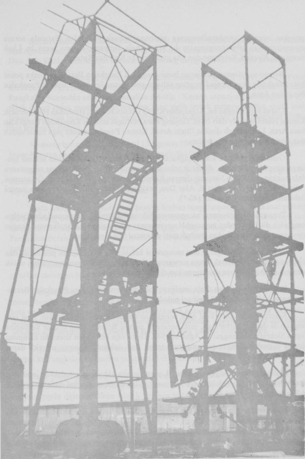
PUING-PUING. Tambang Minyak Pangkalan Berandan yang dibumikanguskan telah menjadi puing-puing berserakan dan berantakan. Para pejuang merelakannya hangus menjadi debu daripada jatuh ke tangan kolonialisme Belanda. Setelah KMB (Konperensi Meja Bundar) barulah puing-puing itu dibenahi lagi dan sejak Orde Baru muncul sebagai asset nasional salahsatu pilar pembangunan nasional. (Foto : Pertamina).
