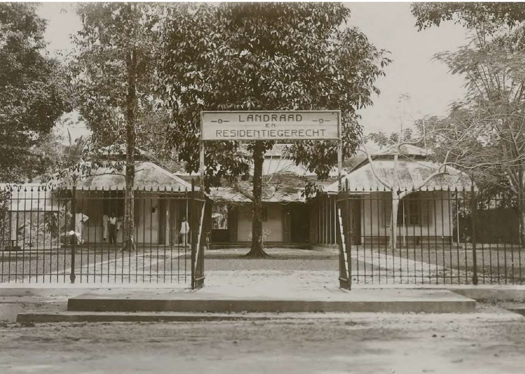
Gambar 2.8 Gedung Landraad dan Residentiegericht di Ambon, sekitar tahun 1925. Sumber: Perpustakaan Universitas Leiden
