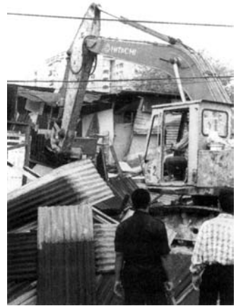
Traktor menggosur paksa rumah-rumah penghuni perkampungan kumuh di Kuala Lumpur, Malaysia.
