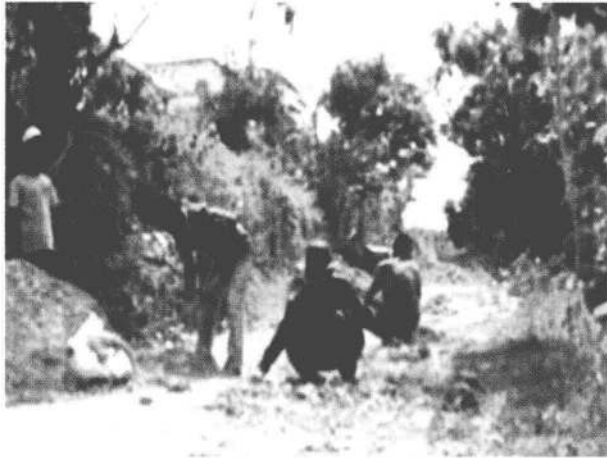
Foto 11: Royongan membuat jalan dusun
