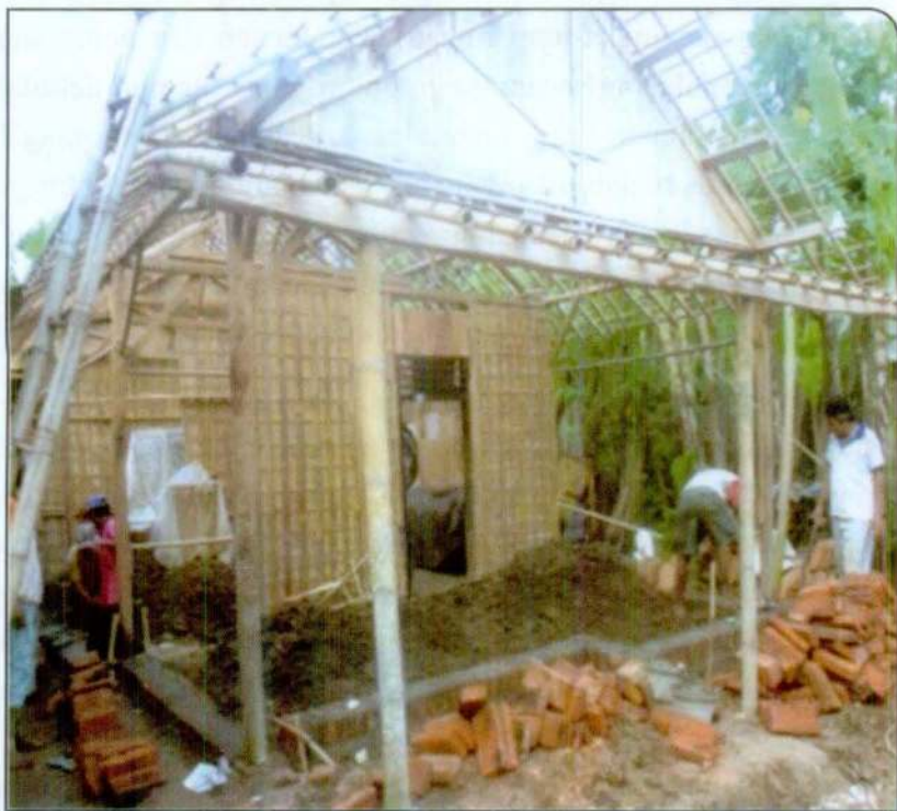
Foto 1: Kerangka Bentuk Rumah Klabang Nyander
