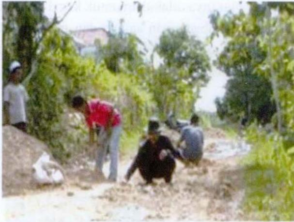
Foto 11: Royongan membuat jalan dusun
