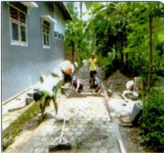
Foto 3: Pemasangan Konblok
