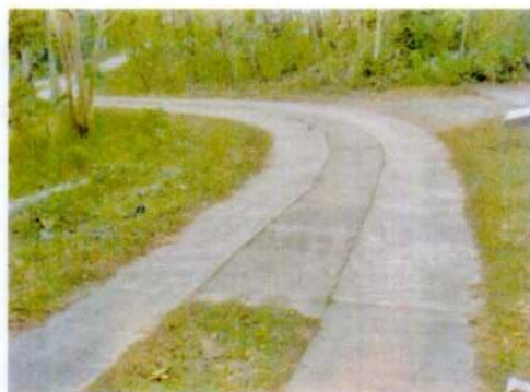
Foto 2. Jalan beton bantuan PNPM Mandiri Pedesaan
