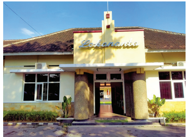
Gedhung Lokananta kang isih njenggereng wibawa (foto yan)
