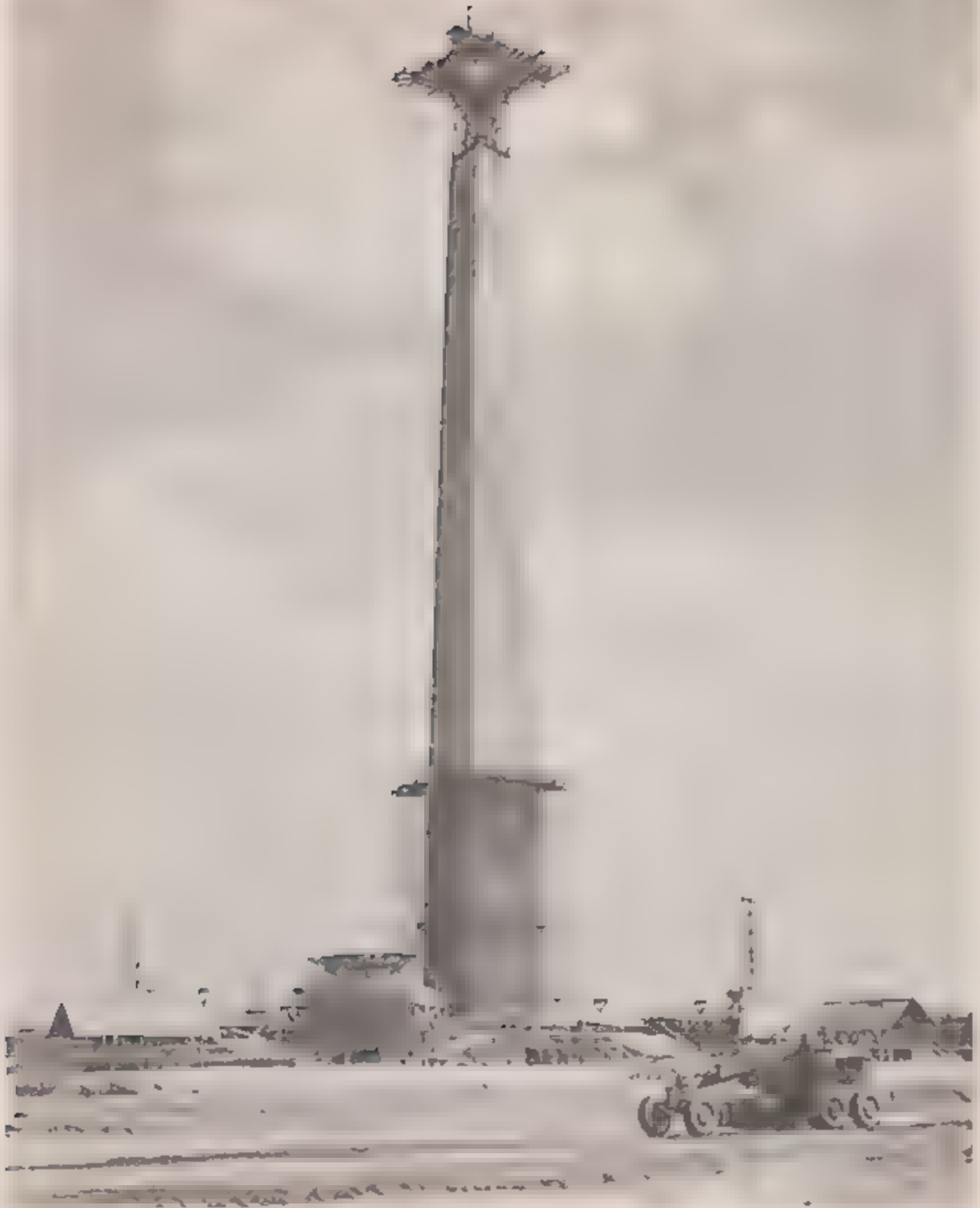
Monumen Tugu Pahlawan 12 Agustus 1963, penambahan rangka besi setinggi 10 m telah selesai dilaksanakan.
