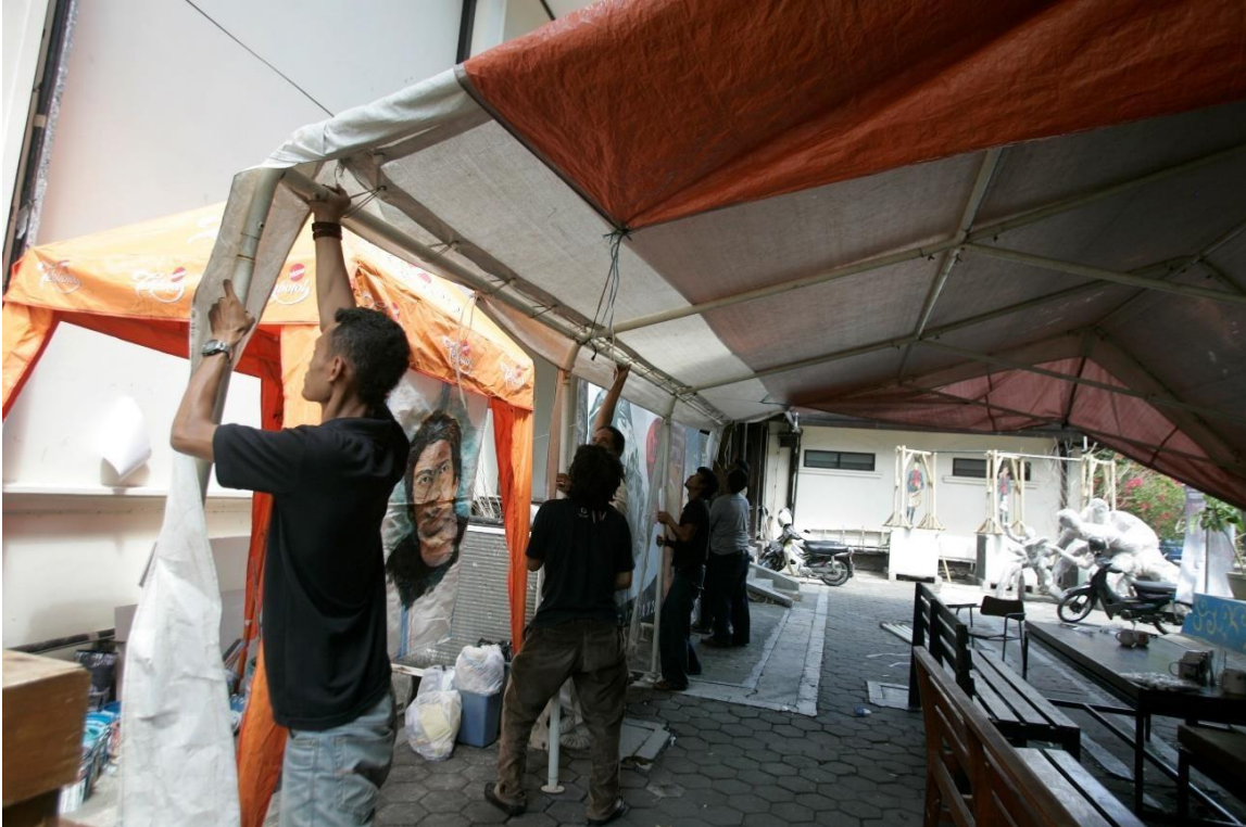
Gambar 3 Pemasangan terpal atap Warung Jamming.
