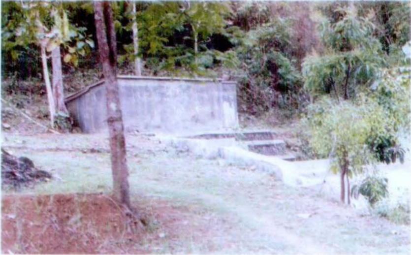
Foto 2.3. Bak Penampung Air di dekat Hutan Wonosadi
