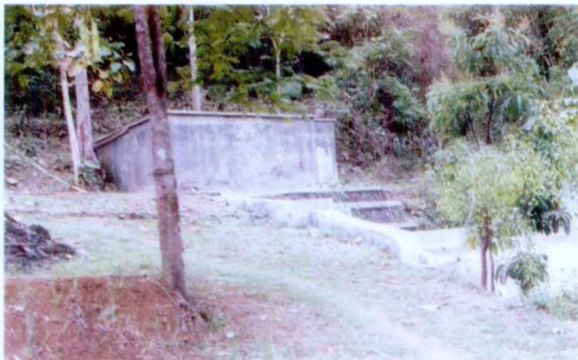
Foto 2.3. Bak Penampung Air di dekat Hutan Wonosadi
