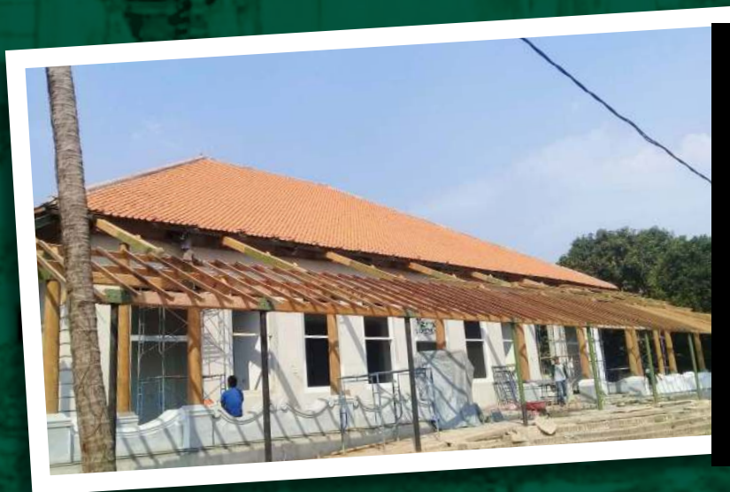
Proses pemugaran landhuis Rumah Cimanggis (02/08/2021). Bangunan hunian yang memadukan unsur budaya membangun lokal dan Eropa kolonial ini berhubungan erat dengan kehidupan Gubernur-Jenderal Verenigde Oost-Indische Compagnie (VOC) Petrus Albertus van der Parra (1761-1775). Sumber foto: Rika Sjoekri
