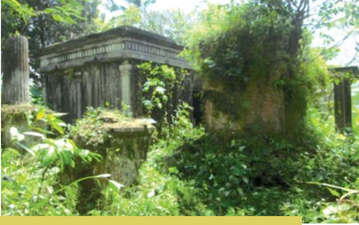
Kondisi Kompleks Kerkop Desentje di Kabupaten Boyolali, Jawa Tengah yang tidak terawat dan dipenuhi tanaman (Sumber : Aga Yurista Pambayun)
