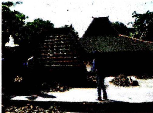
Jalan dan rumah tradisional yang rusak karena gempa di Kotagede (Foto: L.T. Adishakti)
