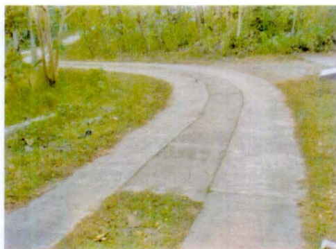
Foto 2. Jalan beton bantuan PNPM Mandiri Pedesaan
